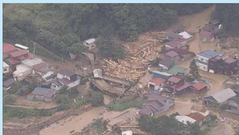
2021年8月 記録的豪雨による土砂災害 国道279号にかかる小赤川橋が崩落
