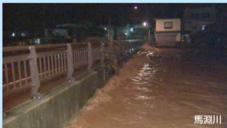
2013年9月 台風による記録的豪雨で 馬淵川中流域や岩木川で氾濫発生
